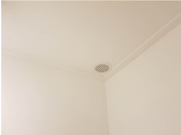
Afb. 11.4 Afvoervoorziening bij natuurlijke ventilatie
