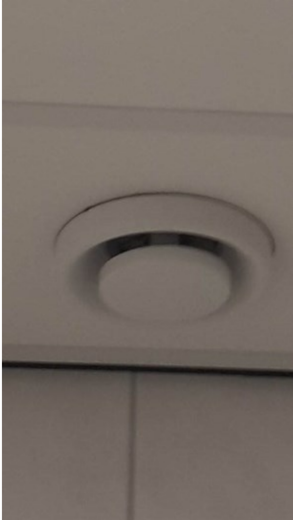
Afb. 11.7 Een afzuigventiel van mechanische ventilatie
