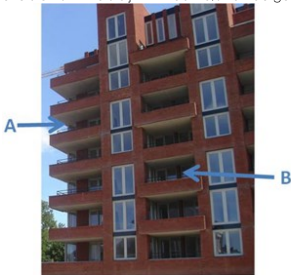
Afb. 16.8 Raam A heeft een overstek en een zijbelemmering, raam B heeft een overstek en twee zijbelemmeringen
