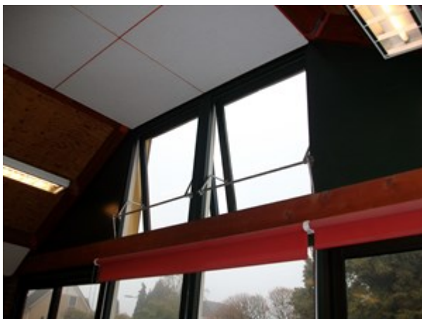
Afb. 11.2 Klepraam voor natuurlijke luchttoevoer
