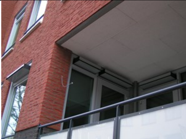
Afb. 11.3 Suskasten boven een raam
